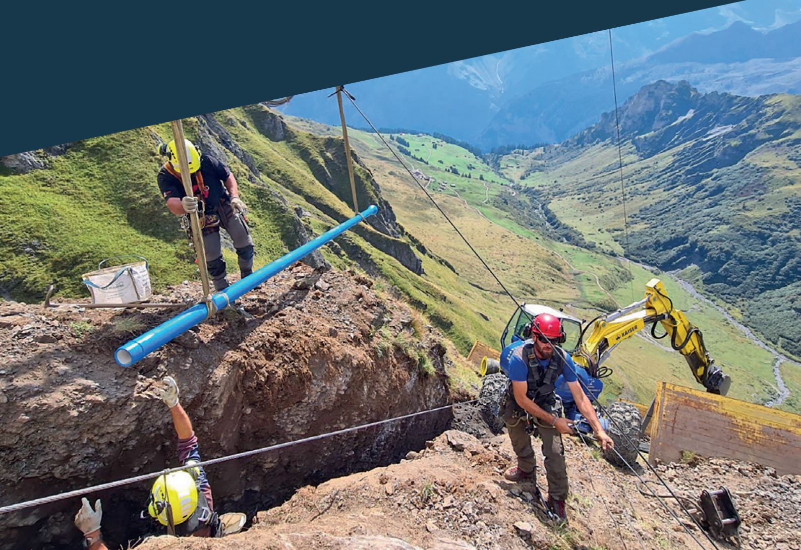
Bauarbeiten Wasserversorgung Schiltalp - Birg
