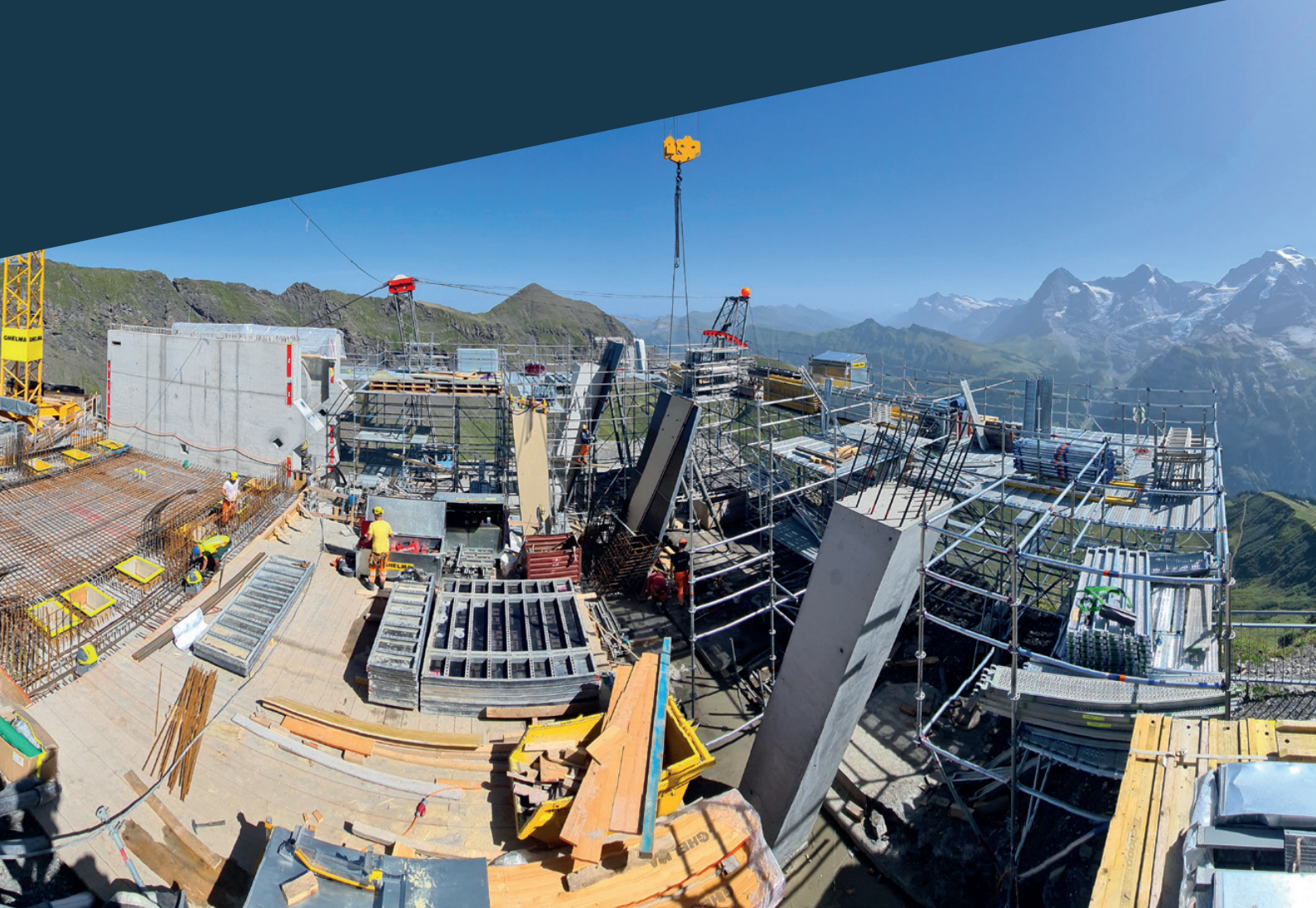
Baustelle Bergstation Birg in der Rohbauphase
