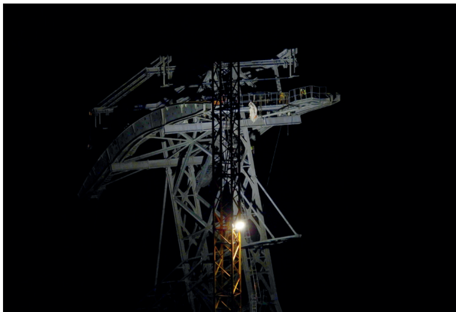
Montagearbeiten Stütze 2 auch nachts
