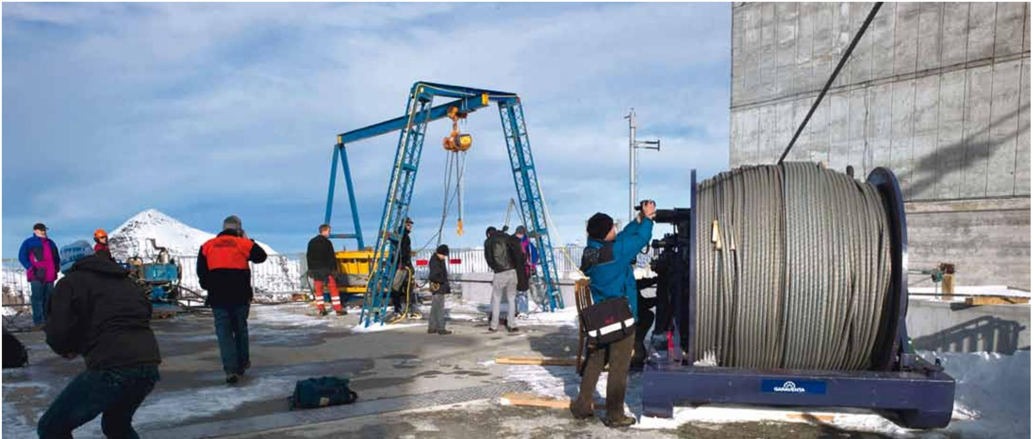
Neben der Station Birg: Das neue Seil wird von der grossen Winde abgerollt und mit dem Antrieb der Bahn nach oben gezogen. Das alte Seil wird auf den gelben Haspel (hinten) aufgerollt.
