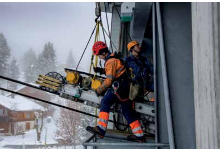
Revisionsarbeiten Stachelberg und Mürren
