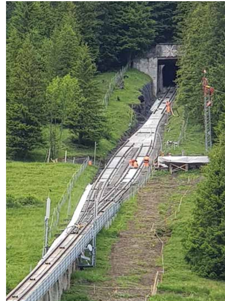
Sanierung Trasse und Unterbau Allmendhubelbahn
