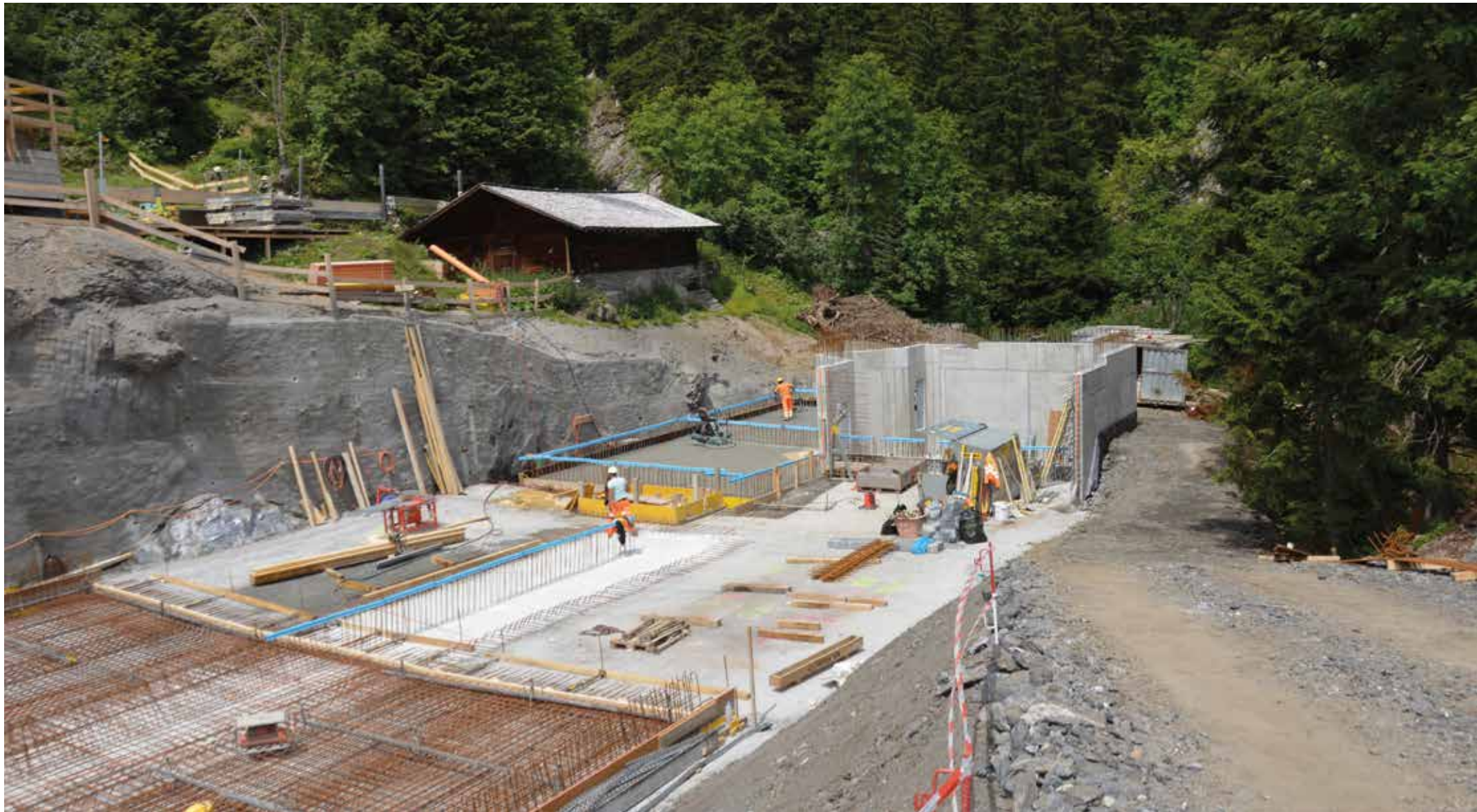
Bau Beschneigungsanlage Reservoir "Giuw"
