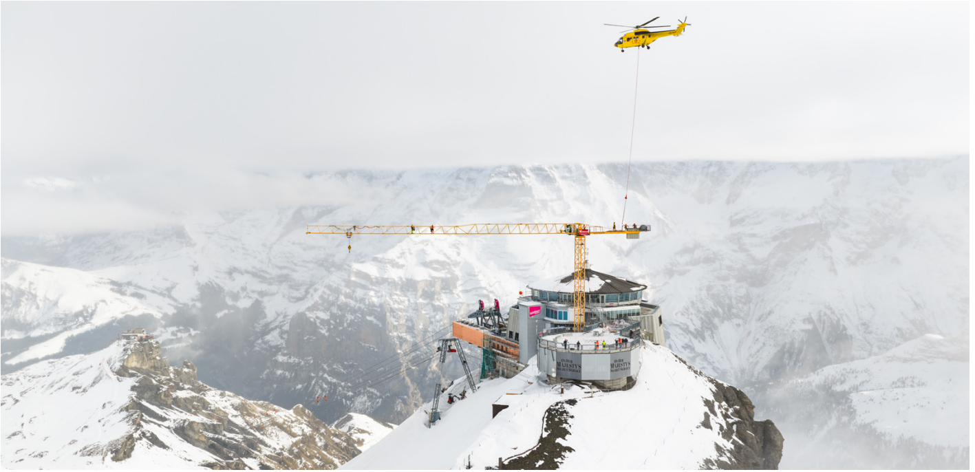
Demontage des Baukrans am Schilthorn - 17. Dezember 2025
