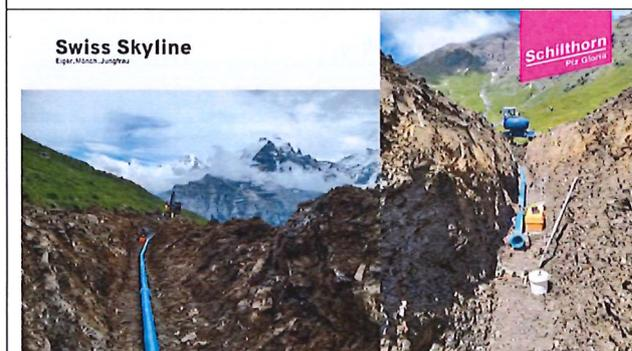
Aktuell wird die Wasserversorgung Birg – Schilthorn realisiert. Bisher wurde das Wasser mit der Kabine ab Mürren bis Birg oder Schilthorn transportiert. Jetzt wird in zwei Etappen (2022 Mürren/Schilt – Birg & 2023 Birg – Schilthorn) eine Wasserversorgung mit Reservoirs auf dem Birg und Schilthorn gebaut. Damit das Wasser unabhängig von der Luftseilbahn nach oben gelangt.
